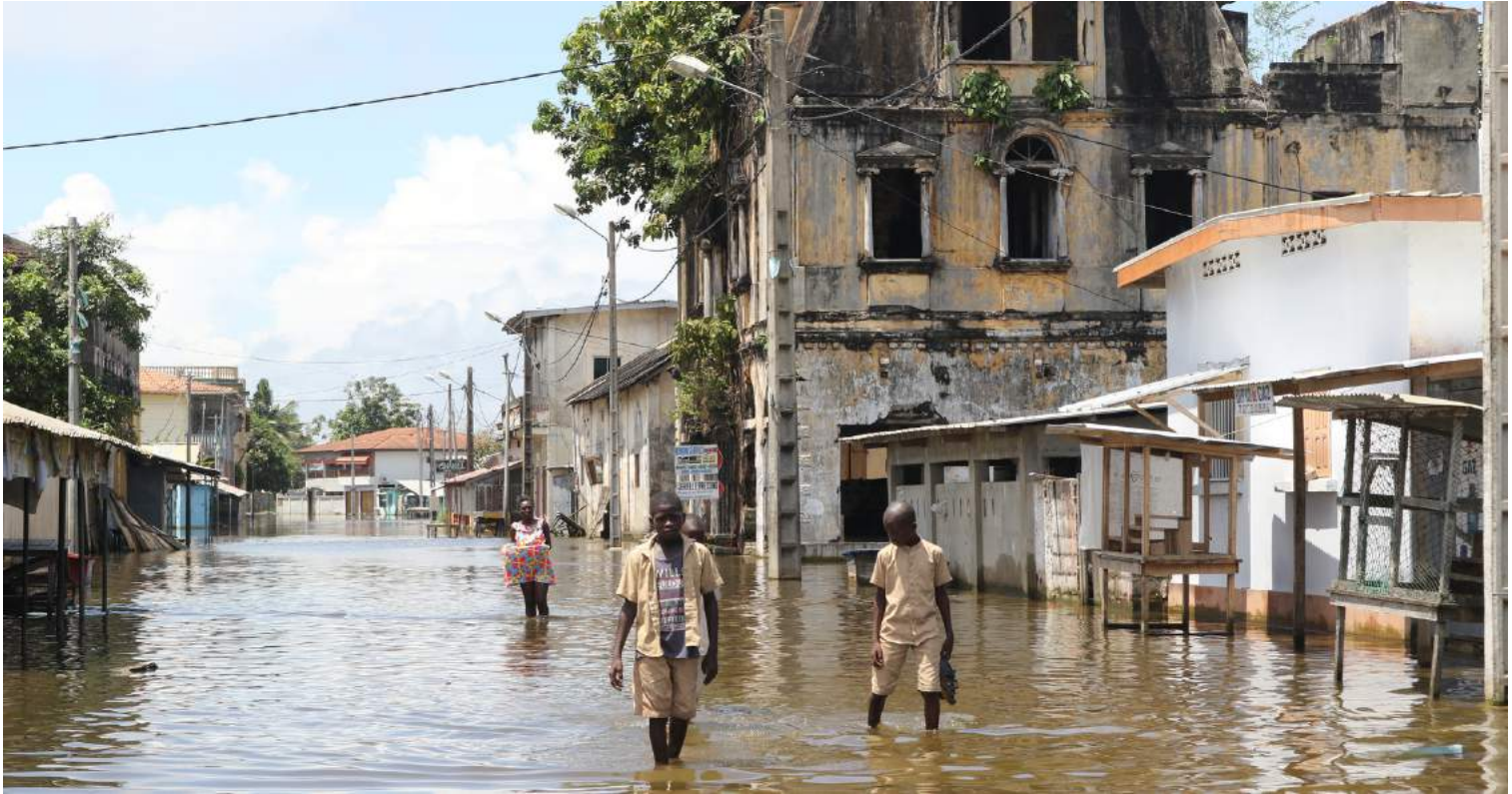
Grand-Bassam sous les eaux
